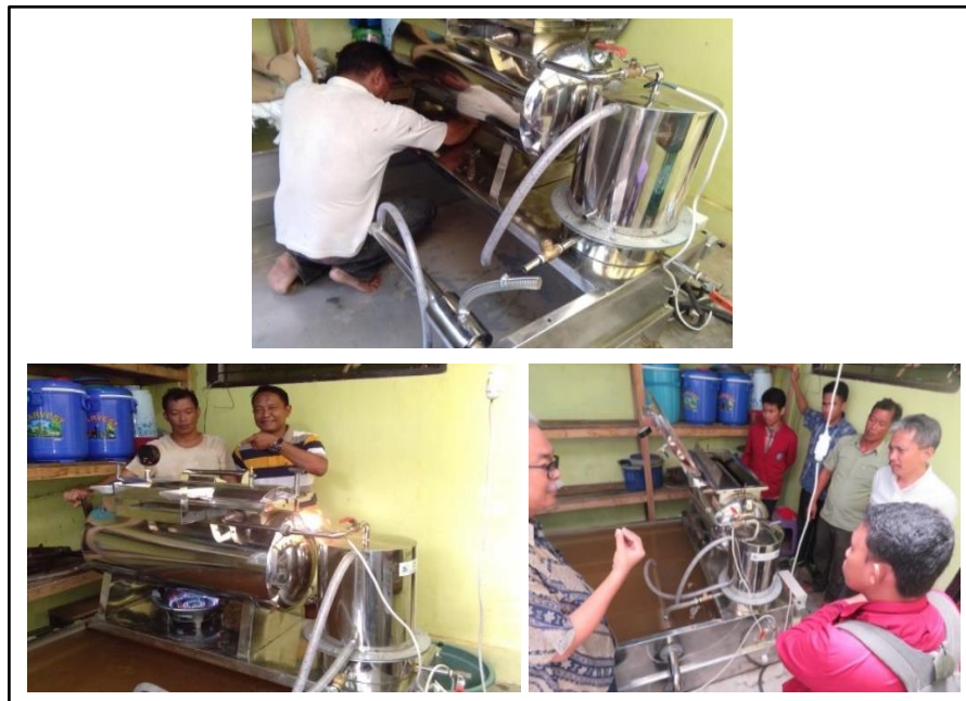
Gambar 4. Perakitan (Atas), instalasi dan uji operasi mesin (bawah)
