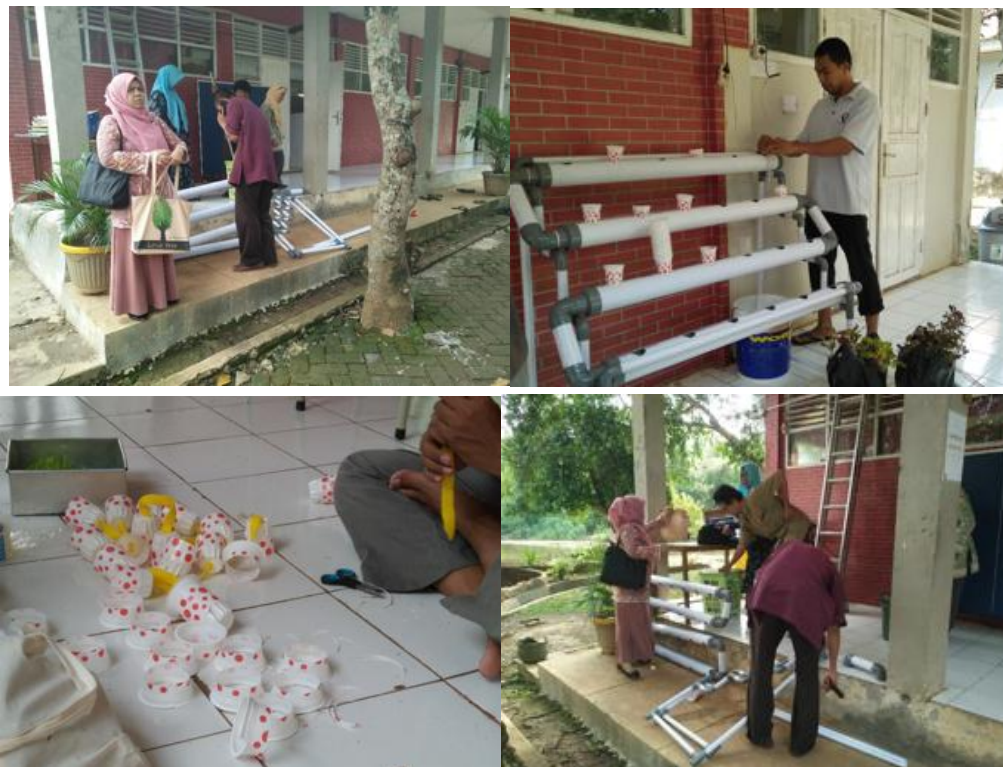
Gambar 2. Penanaman pada instalasi hidroponik berbahan campuran paten dan bahan bekas
