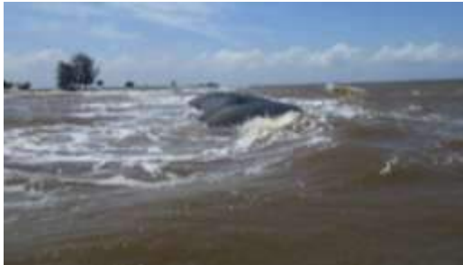
Gambar 4. Gelombang yang masih terjadi di belakang bangunan sabuk pantai (muncul ke permukaan) pada saat posisi air MSL ( Mean Sea Level ).
