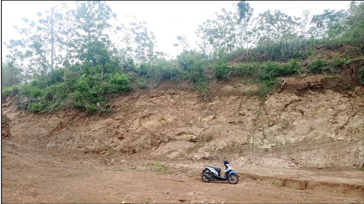
Gambar 7. Kondisi pemotongan lereng
