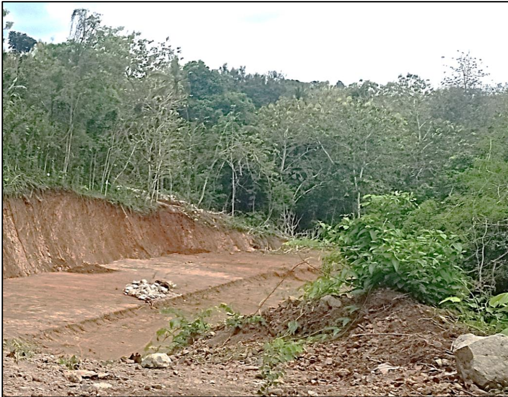
Gambar 4. Kondisi eksisting lokasi penelitian
