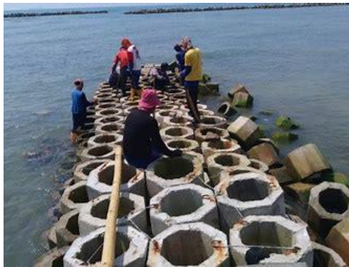
Gambar 6. Pemasangan Groyne
