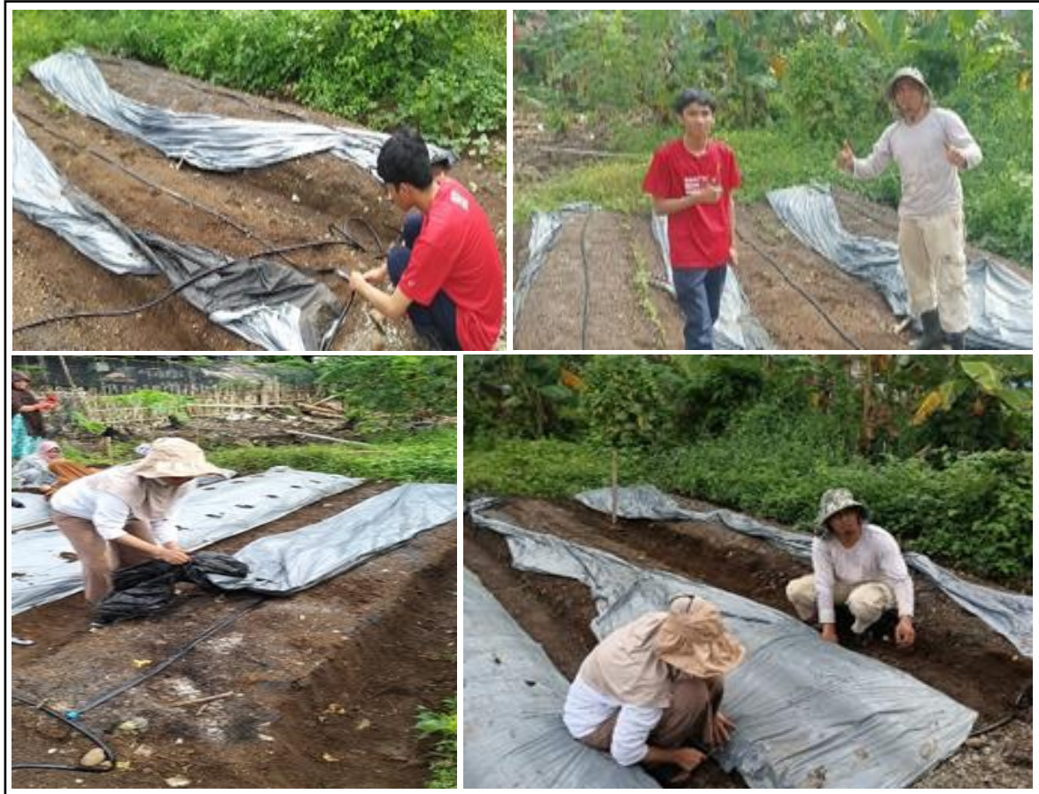
Gambar 9. Pemasangan selang dripline dan driptape 16 mm di lokasi 1.
